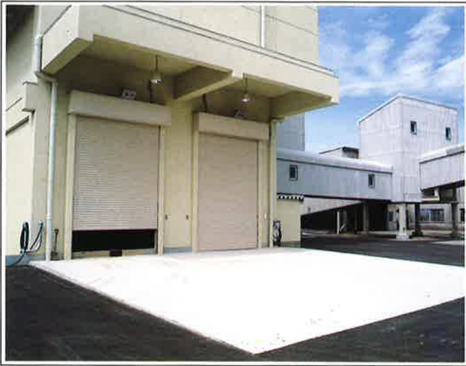
プラットフォーム及びごみ投入扉
