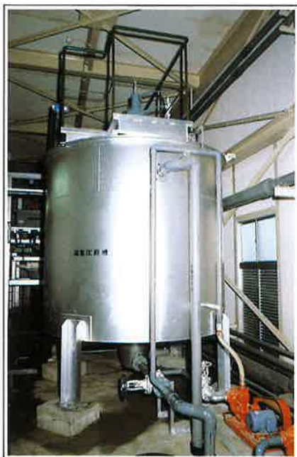
凝集沈でん槽
