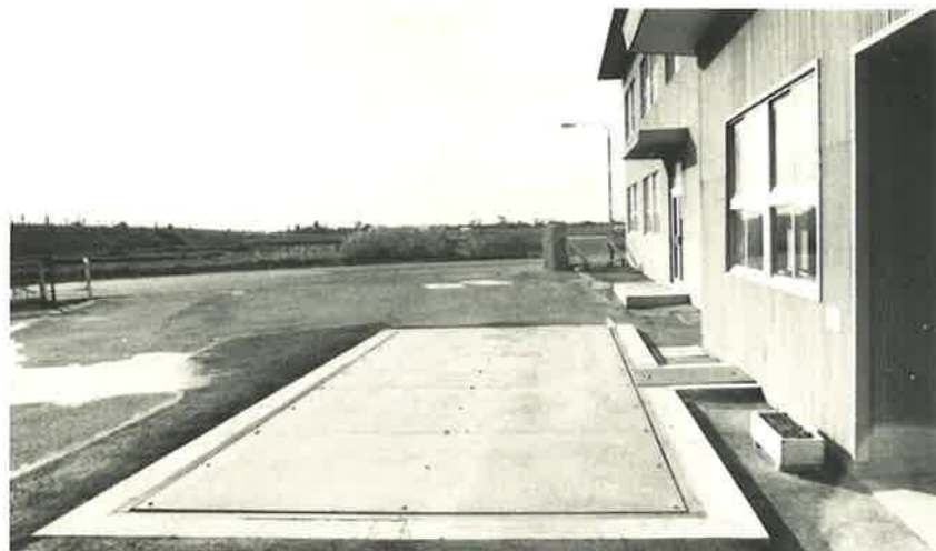
● トラックスケール 収集車で集められたゴミはここで計量されてから、ゴミピットへ運ばれます。
