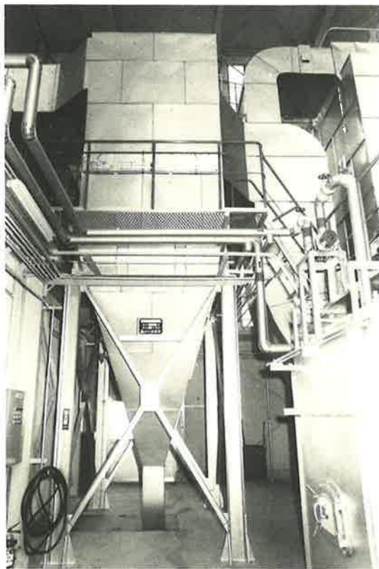
① マルチサイクロン集塵装置 排ガス中のダストを機械的に除去します。
