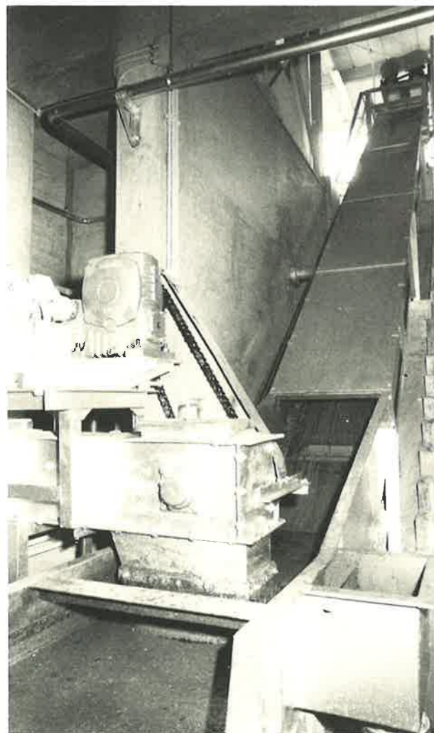
③ 灰出フライトコンベヤ 炉からの灰やダストは水中を通過して灰出バンカへ運ばれます。
