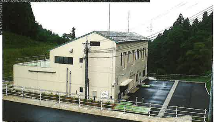
▲浸出水処理施設
